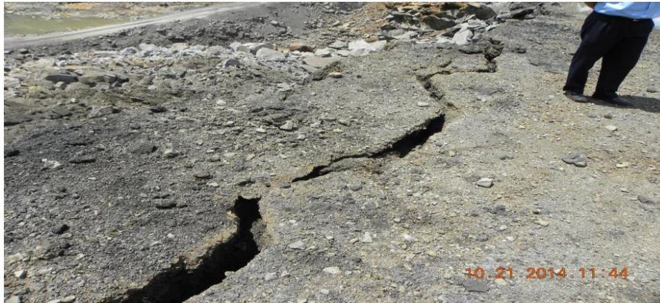
**Figura 16:** Rachaduras na face livre da bancada.
