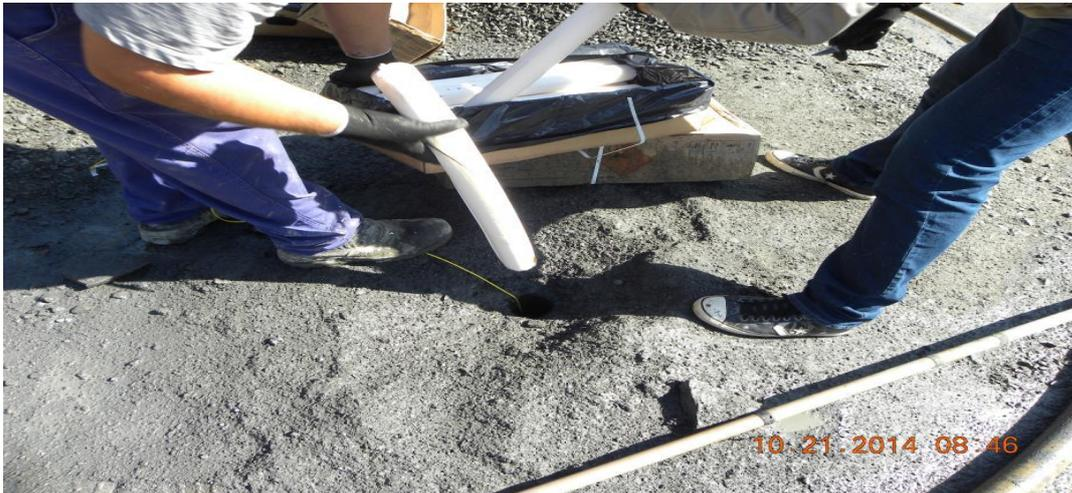
**Figura 18:** Processo de carregamento dos explosivos nos furos da bancada.
